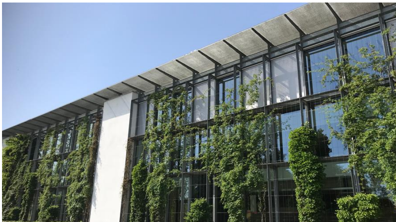
Gebäude Hammertor / Sinslerstrasse 65/67, 6330 Cham
